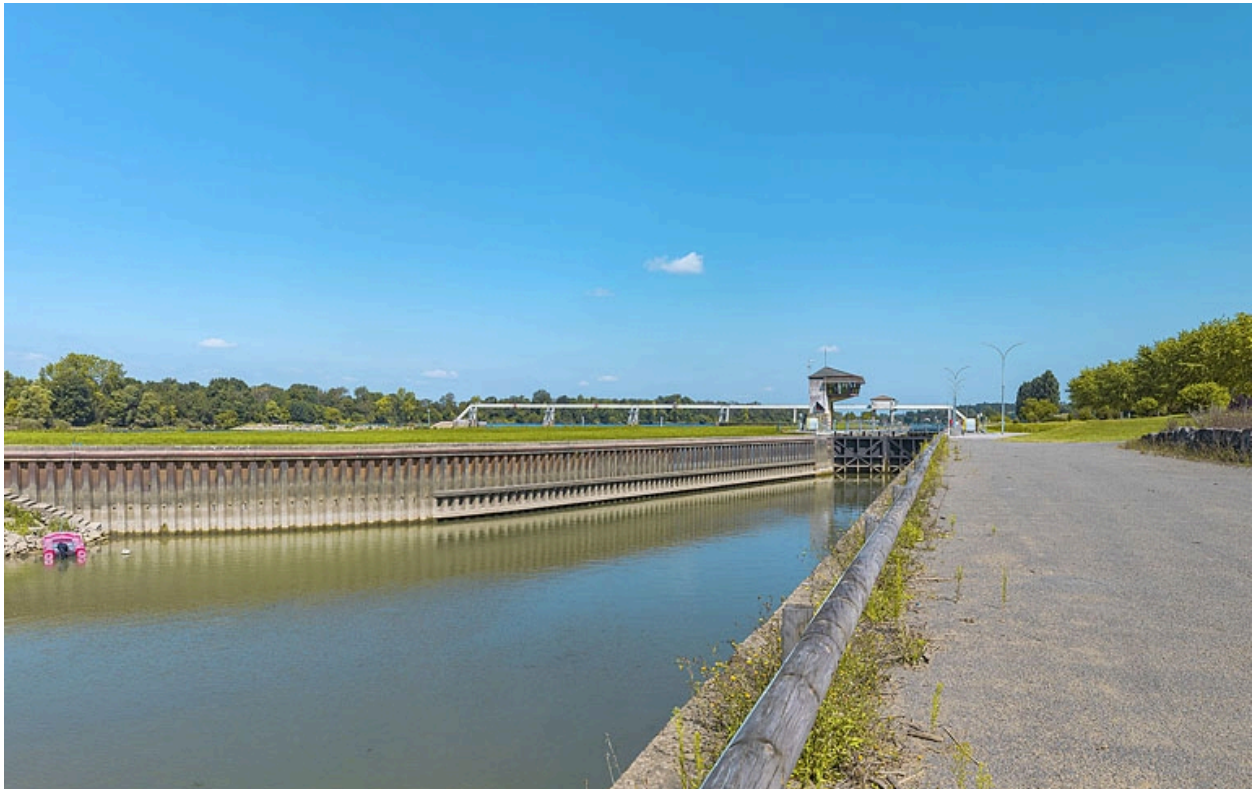
Murs-guides à l'aval du site d'écluse.
