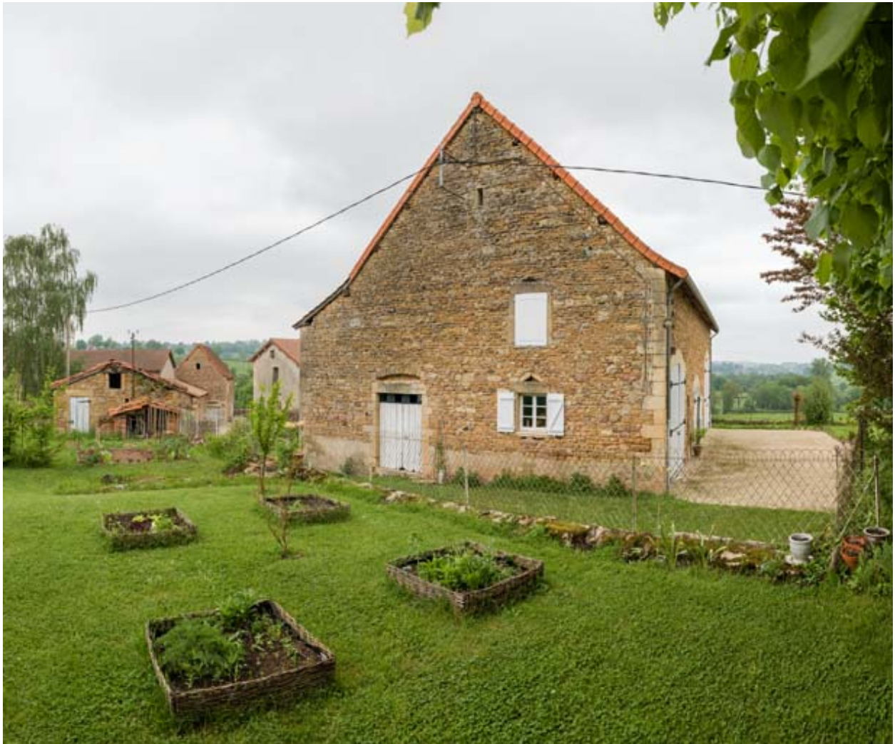
Pignon sud de l'étable.
