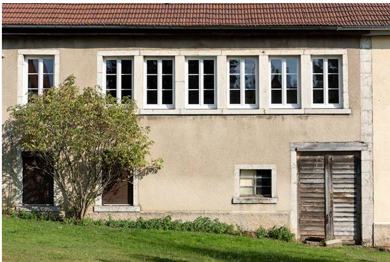
Façade postérieure : fenêtres multiples.
