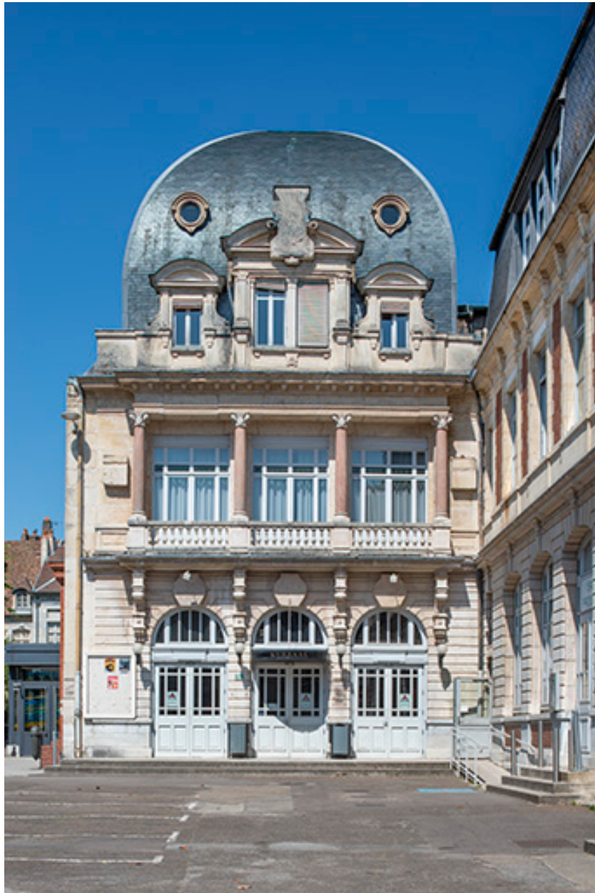
Bâtiment d'entrée : façade antérieure.
