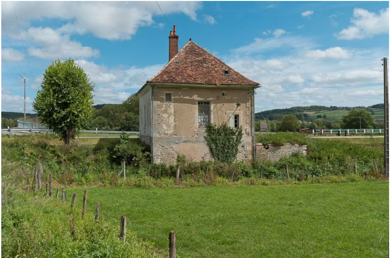
Vue de l'arrière de la maison éclusière.
