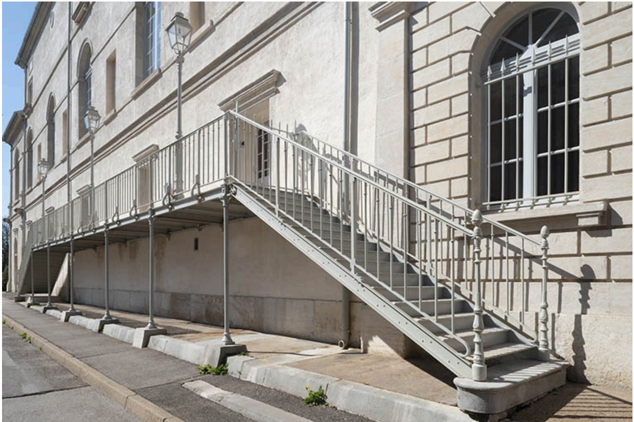
Corps central, façade latérale gauche : escalier de secours et galerie.
