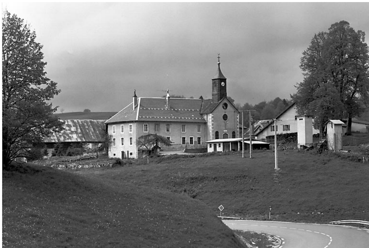
Vue d'ensemble dans le site.
