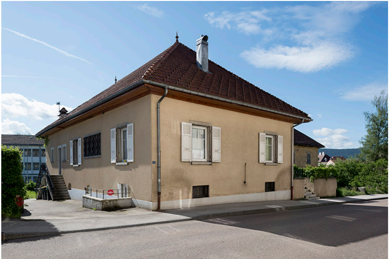
Corps nord : façades antérieure et latérale gauche.
