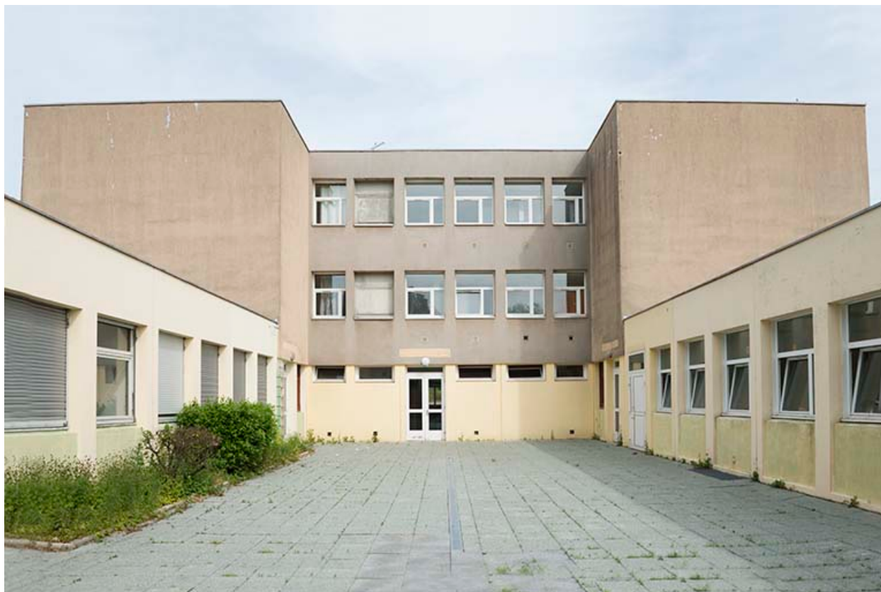
Cour postérieure du bâtiment d'internat et restauration.
