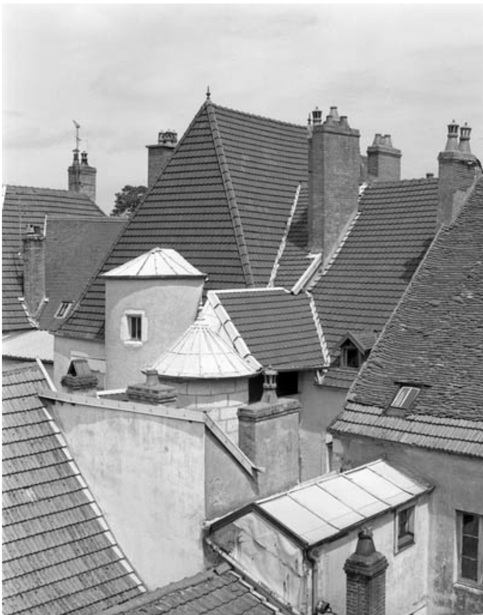
Façade postérieure : vue des toitures.
