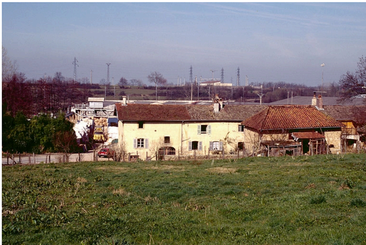
Usine de taille de matériaux de construction Carron, à Saint-Amour : vue d'ensemble, depuis le sud-est.
