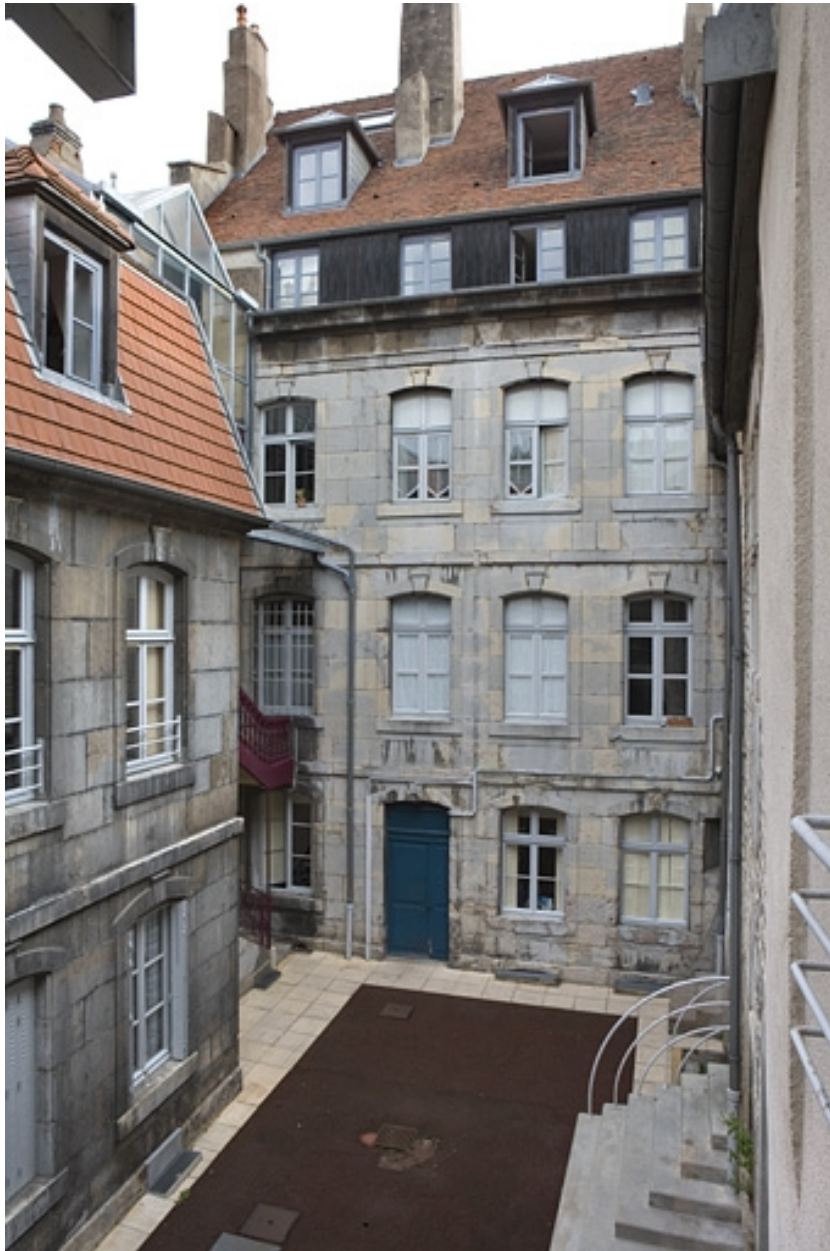
Vue d'ensemble de la cour depuis le fond.
