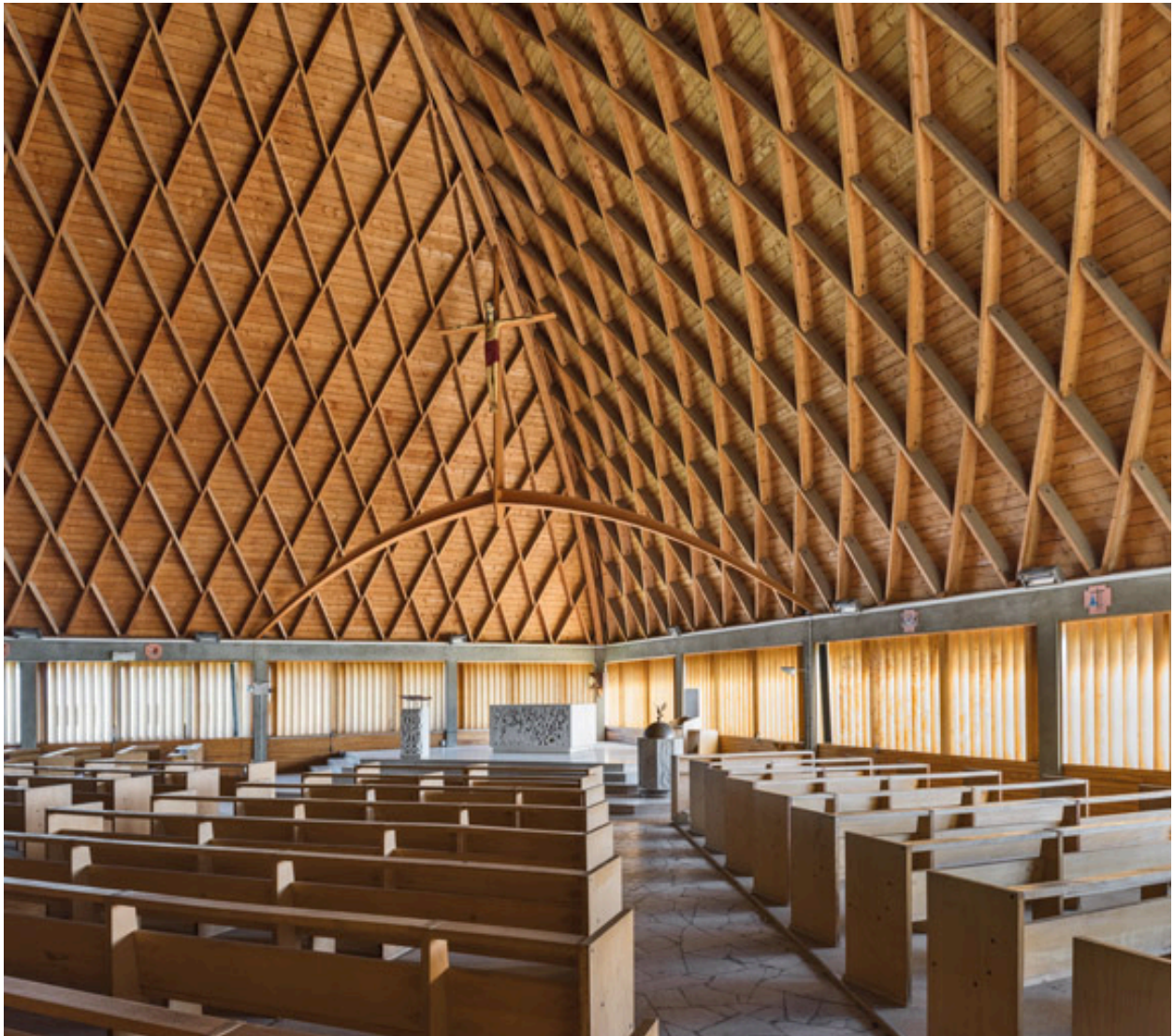
Chœur. Vue depuis le côté sud de la nef, de trois quarts.
