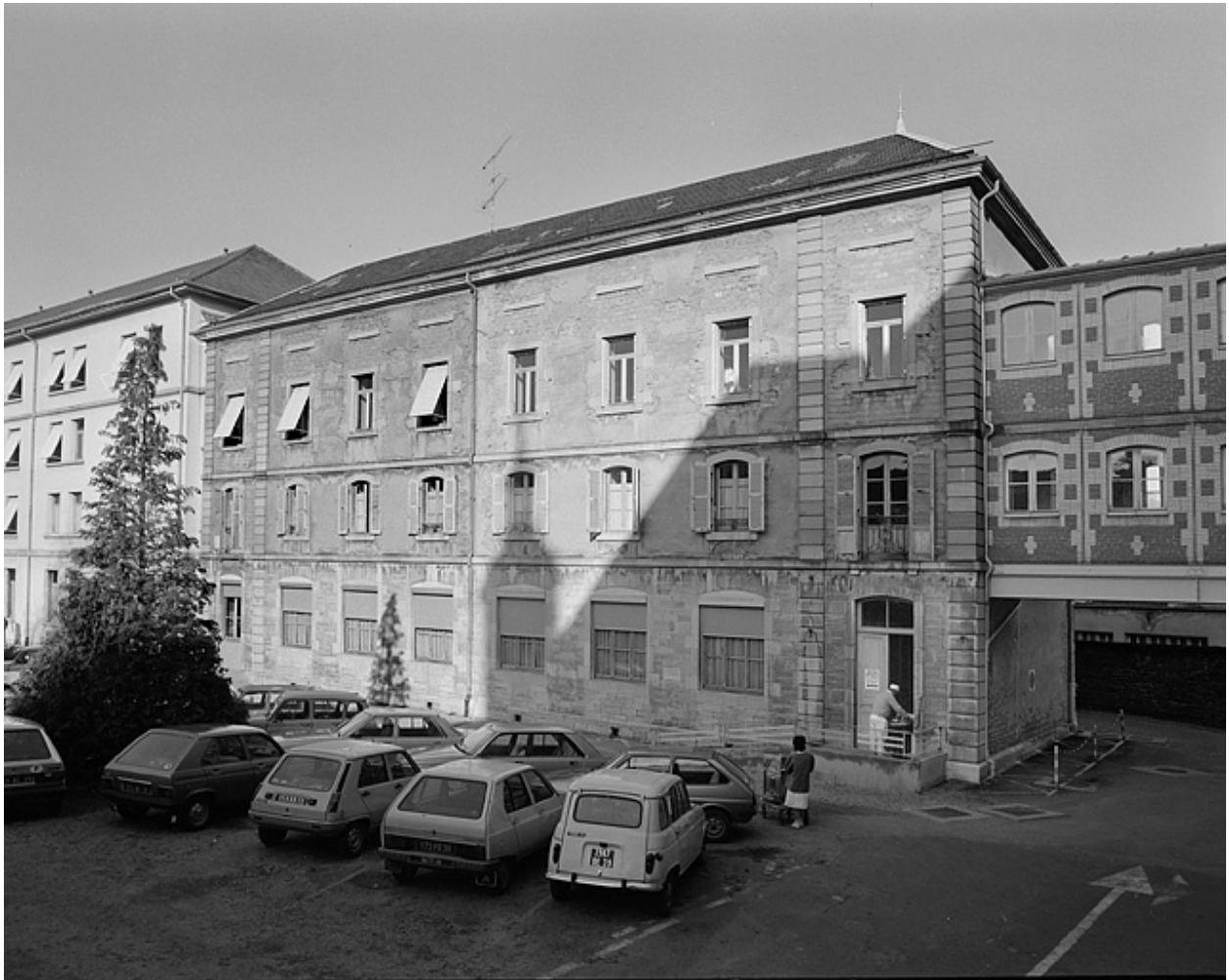
Bâtiment annexe (Pavillon nord) depuis la cour.
