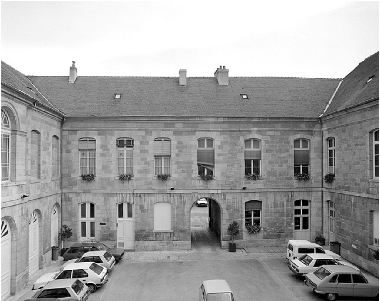
Cour intérieure, côté est.
