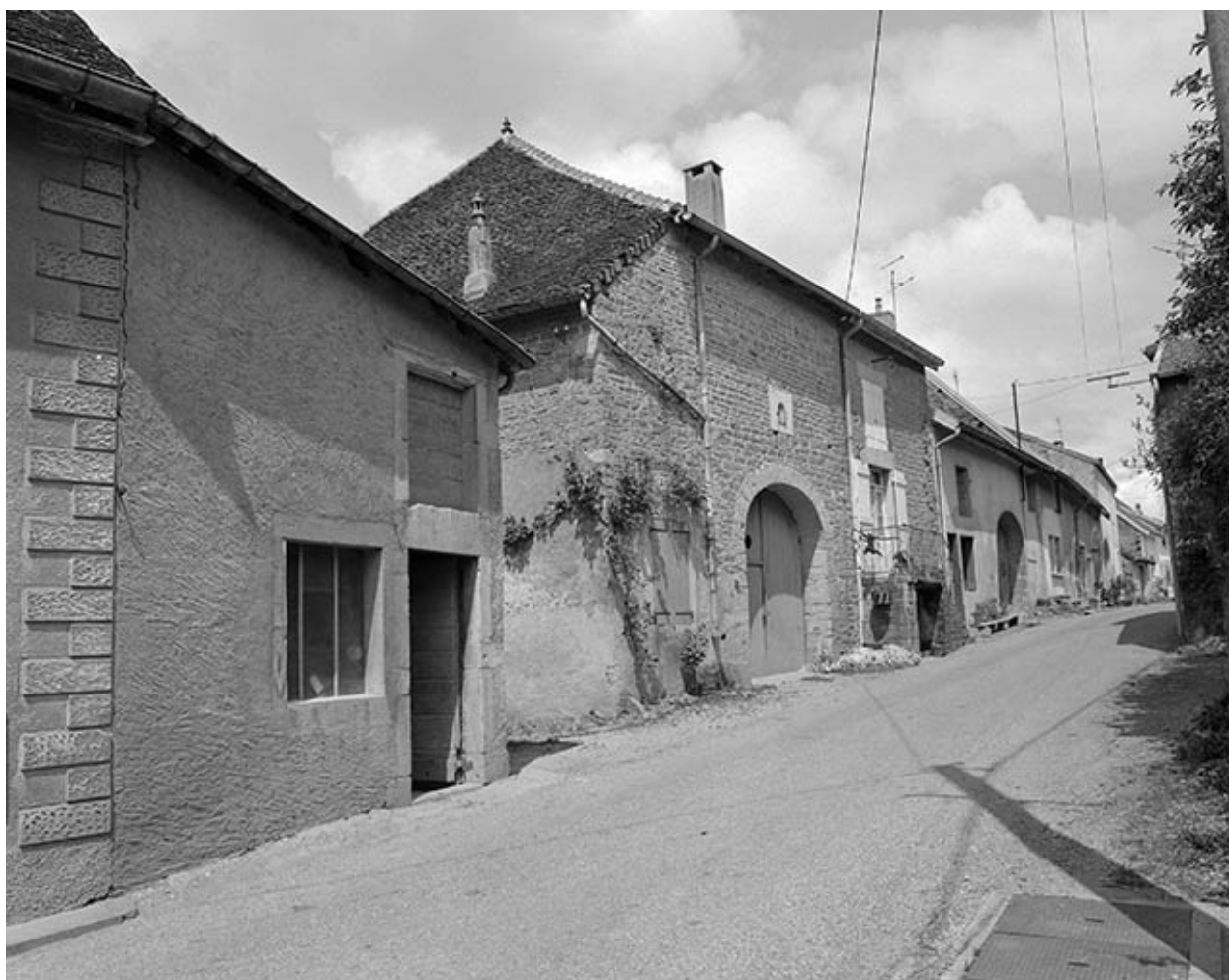
Ferme située rue Chateraine.
