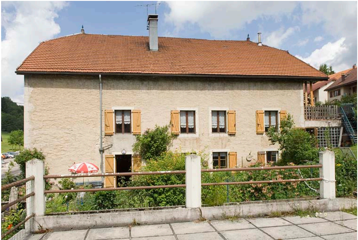
Façade latérale droite.
