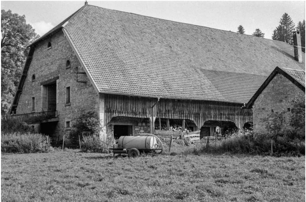
Façades postérieure et latérale gauche.
