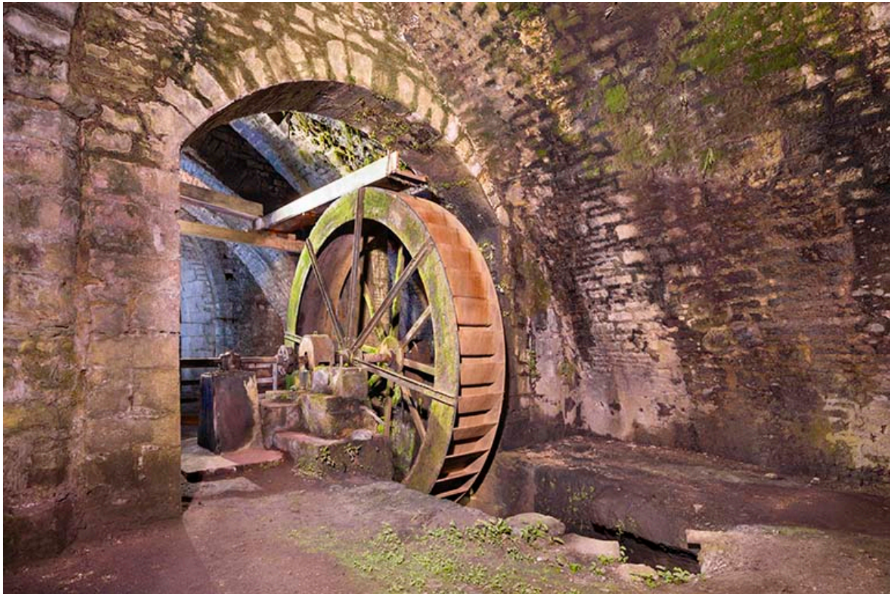
Roue hydraulique en-dessus du puits d'Amont.
