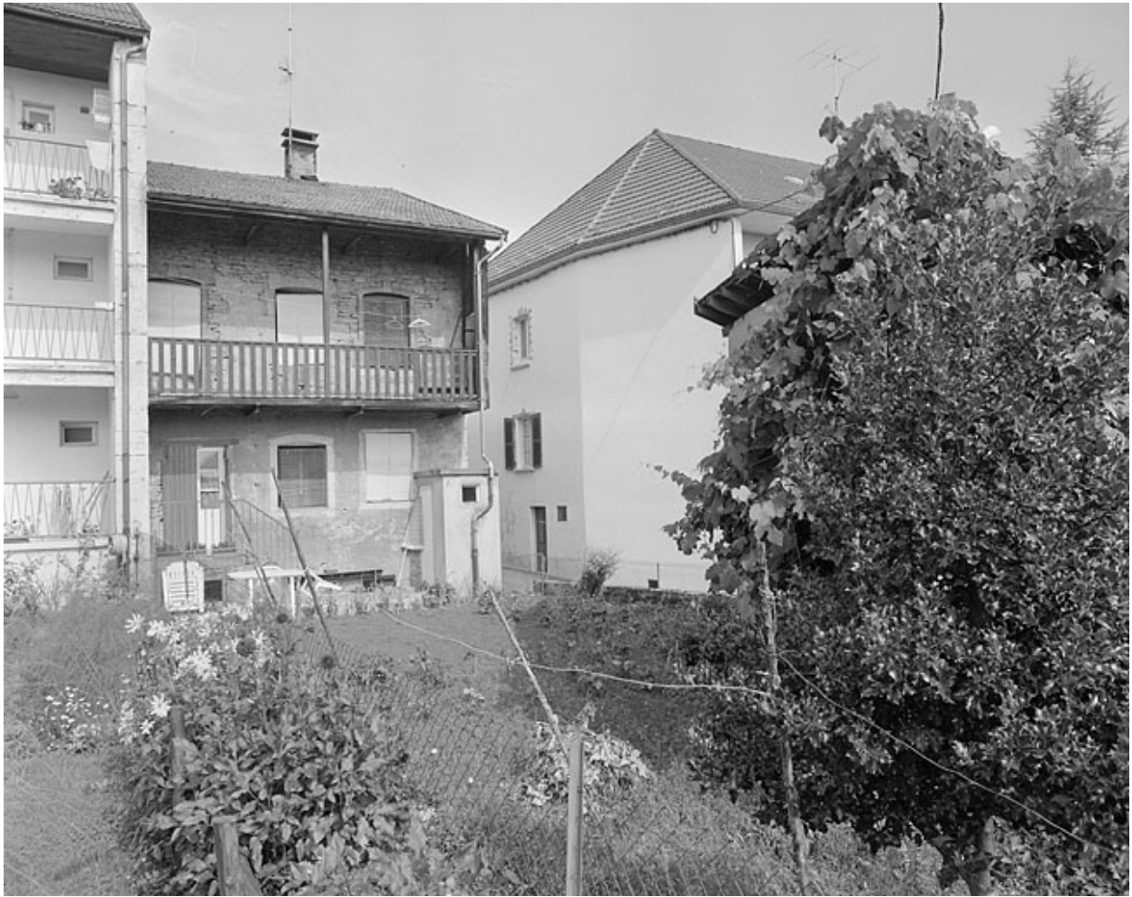
Façade postérieure avec balcon en galerie.
