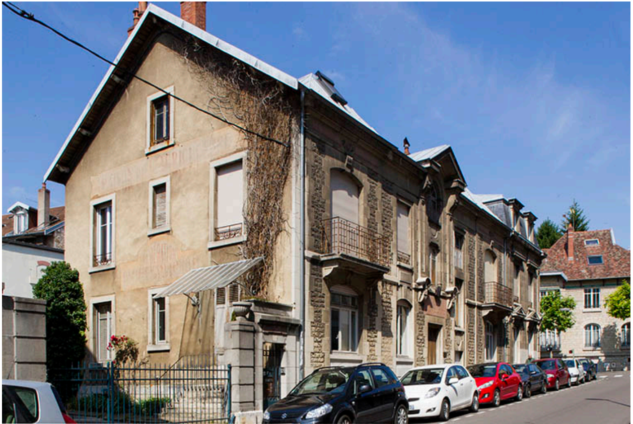
Bâtiment de l'administration : façade antérieure (rue Delavelle), de trois quarts gauche.
