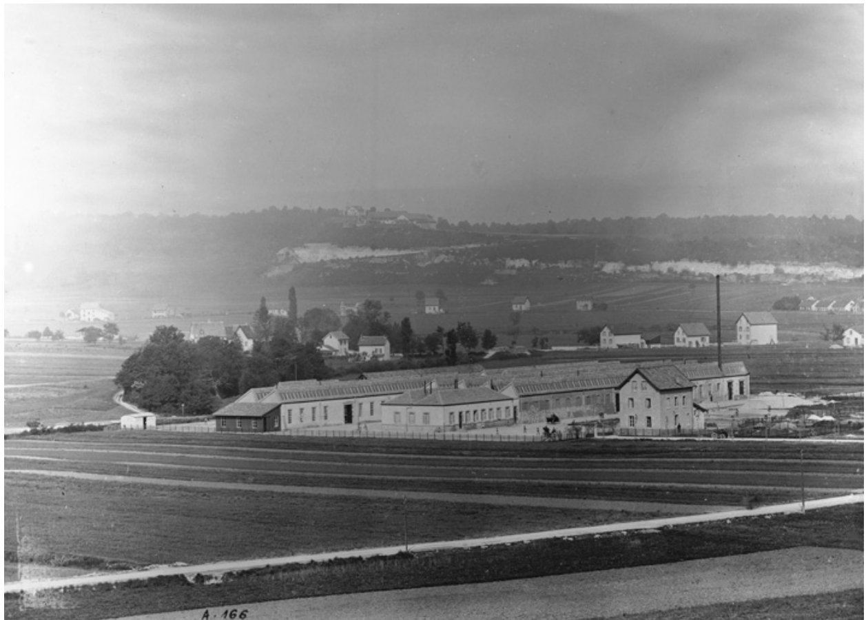
L'usine en construction. Photogr., s.n., s.d. [vers 1898].
