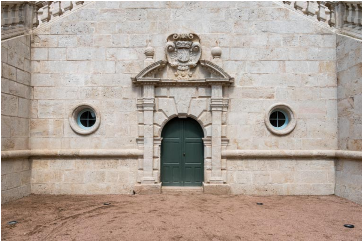
Façade sud-est, partie droite, mur d'échiffre du grand-degré.
