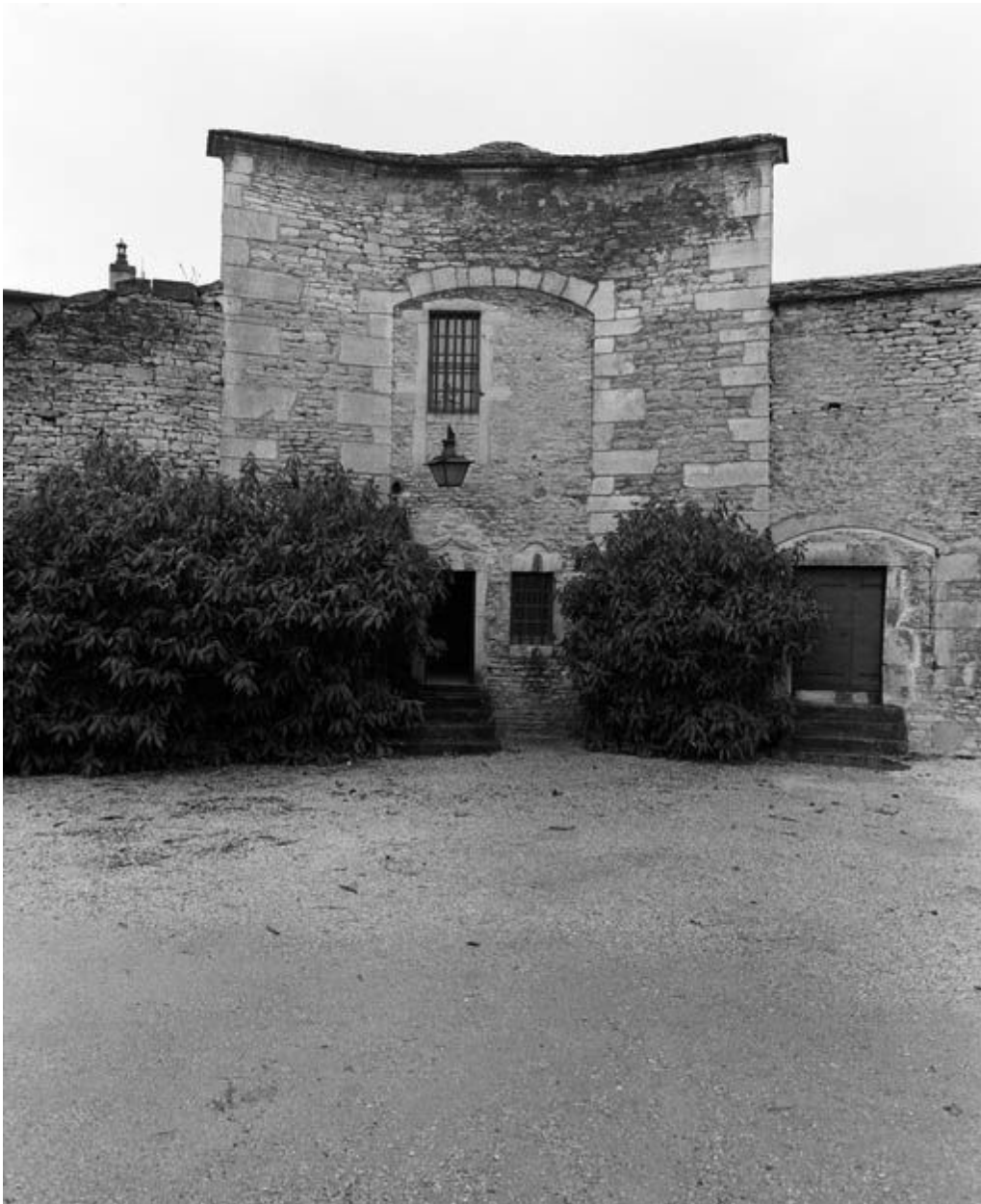
Tour des Cordeliers incluse dans la "grosse tour" (improprement appelée bastion de l'Hôtel-Dieu), depuis le rempart (1992).
