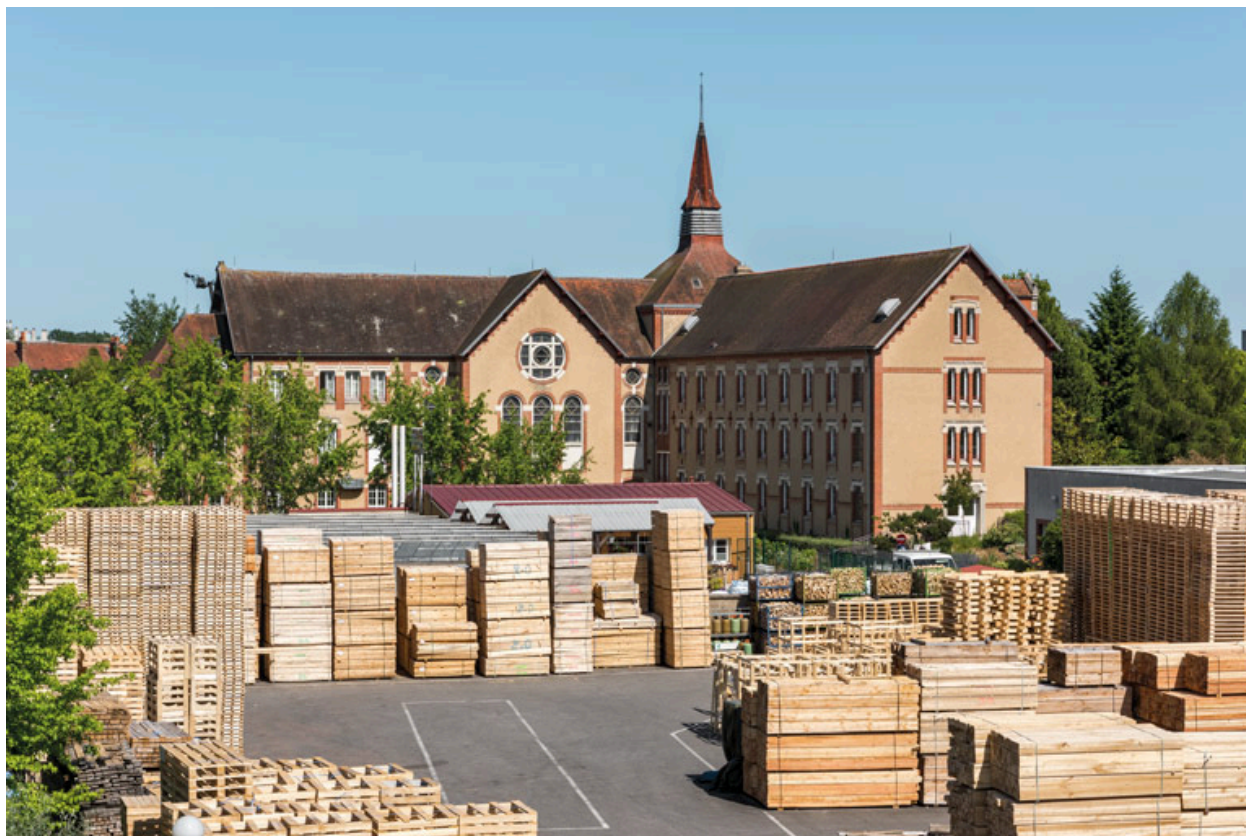
Vue d'ensemble du séminaire devenu ESAT et de l'espace de fabrication et de stockage des palettes.
