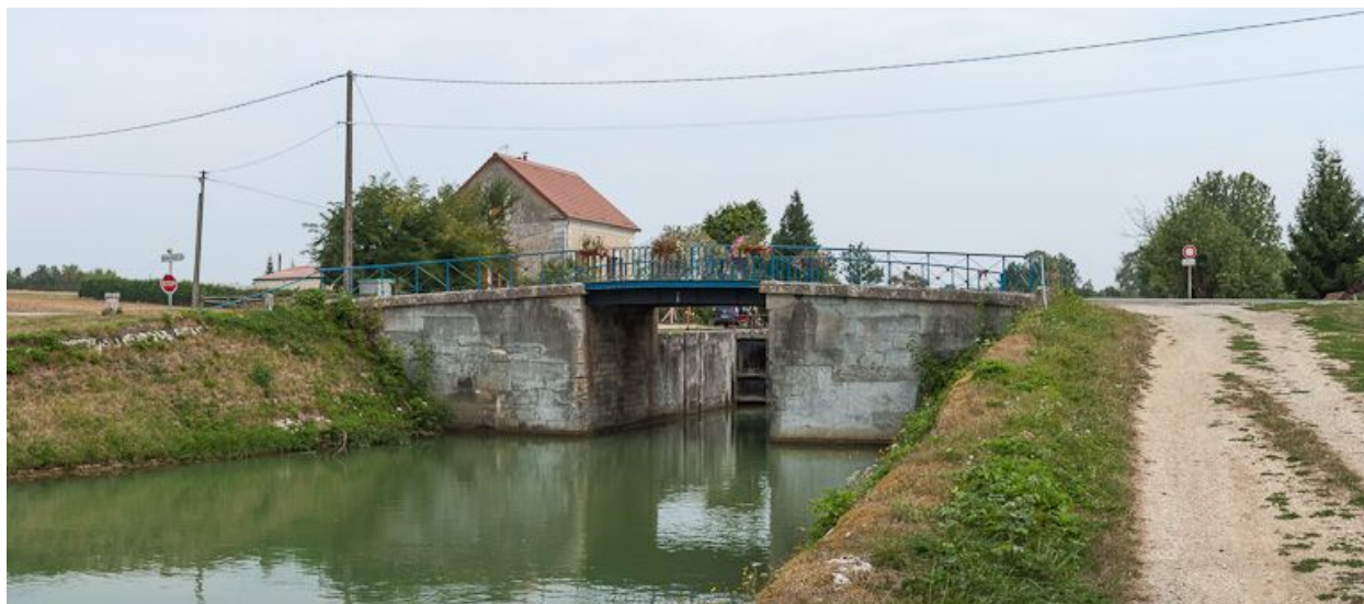
Le pont vu d'aval.
