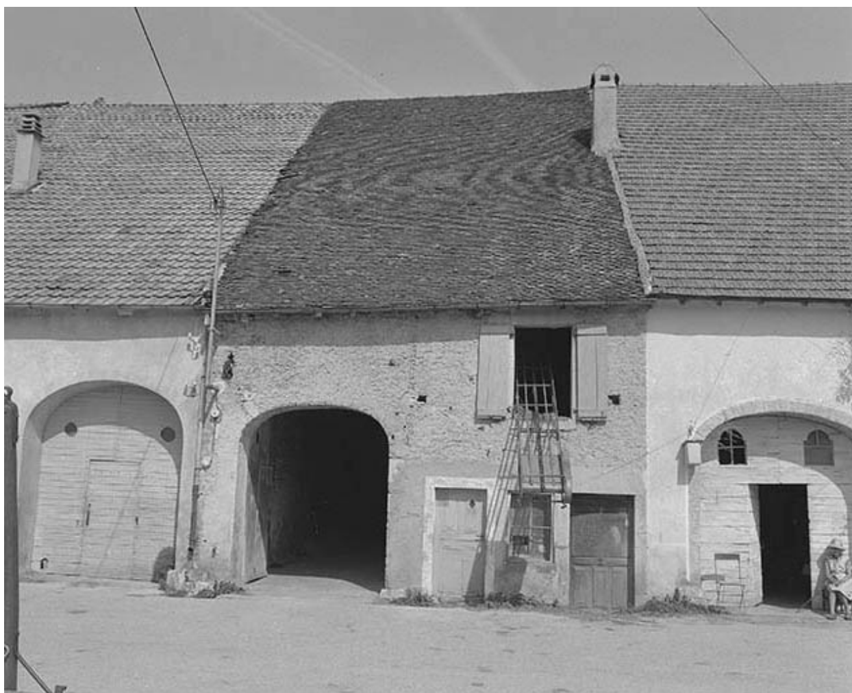
Ferme située à Châtillon.
