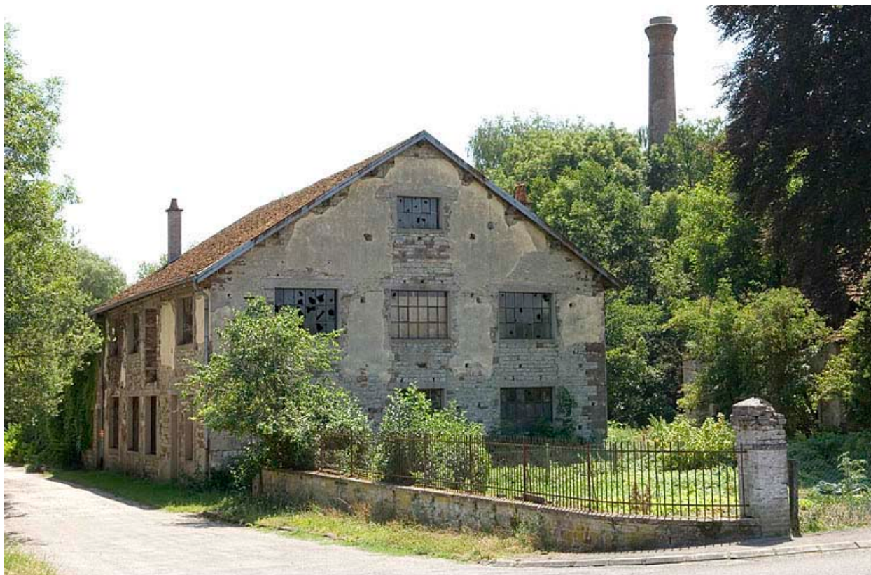
Vue d'ensemble depuis l'entrée.
