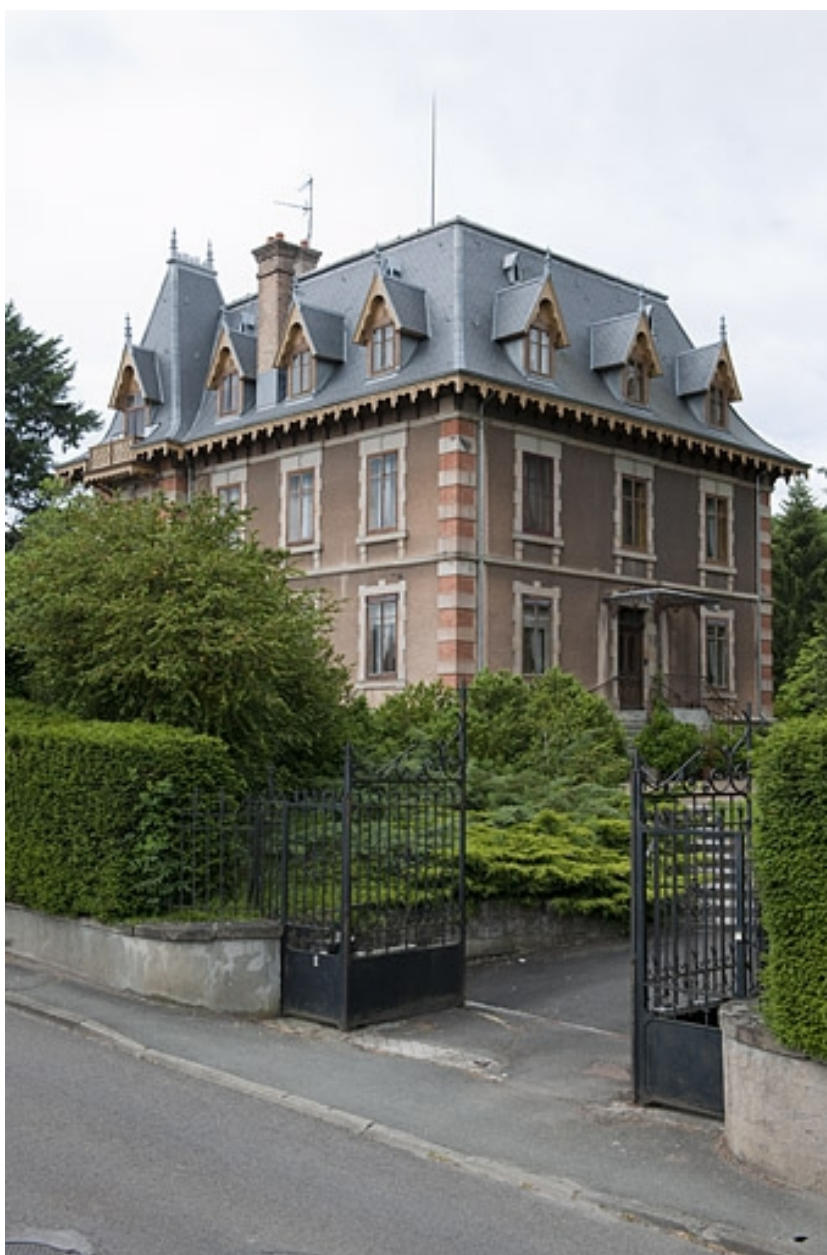
Logement patronal. Vue d'ensemble.
