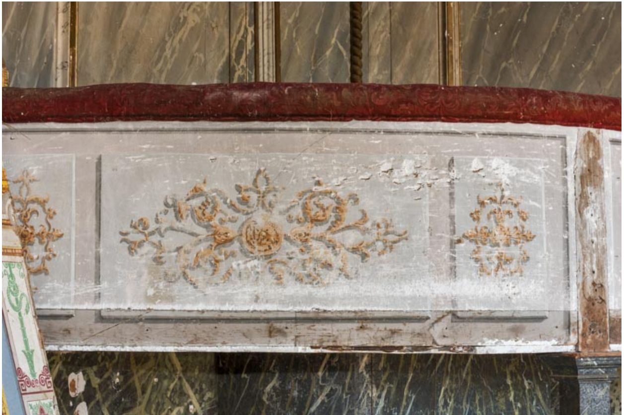
Peinture sur le garde-corps du balcon.
