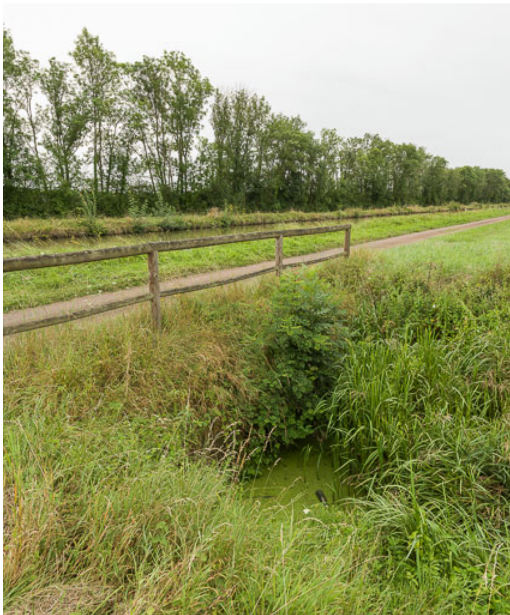
Vue de l'aqueduc.
