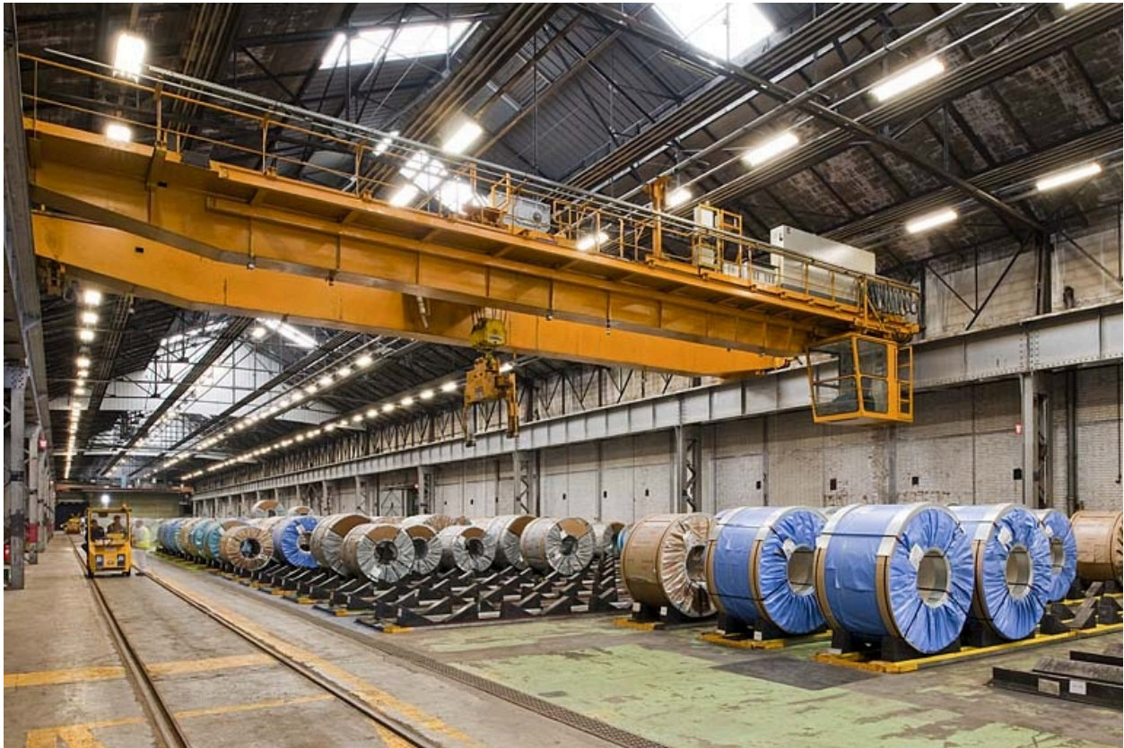
Entrepôt de réception des bobines d'acier (1).
