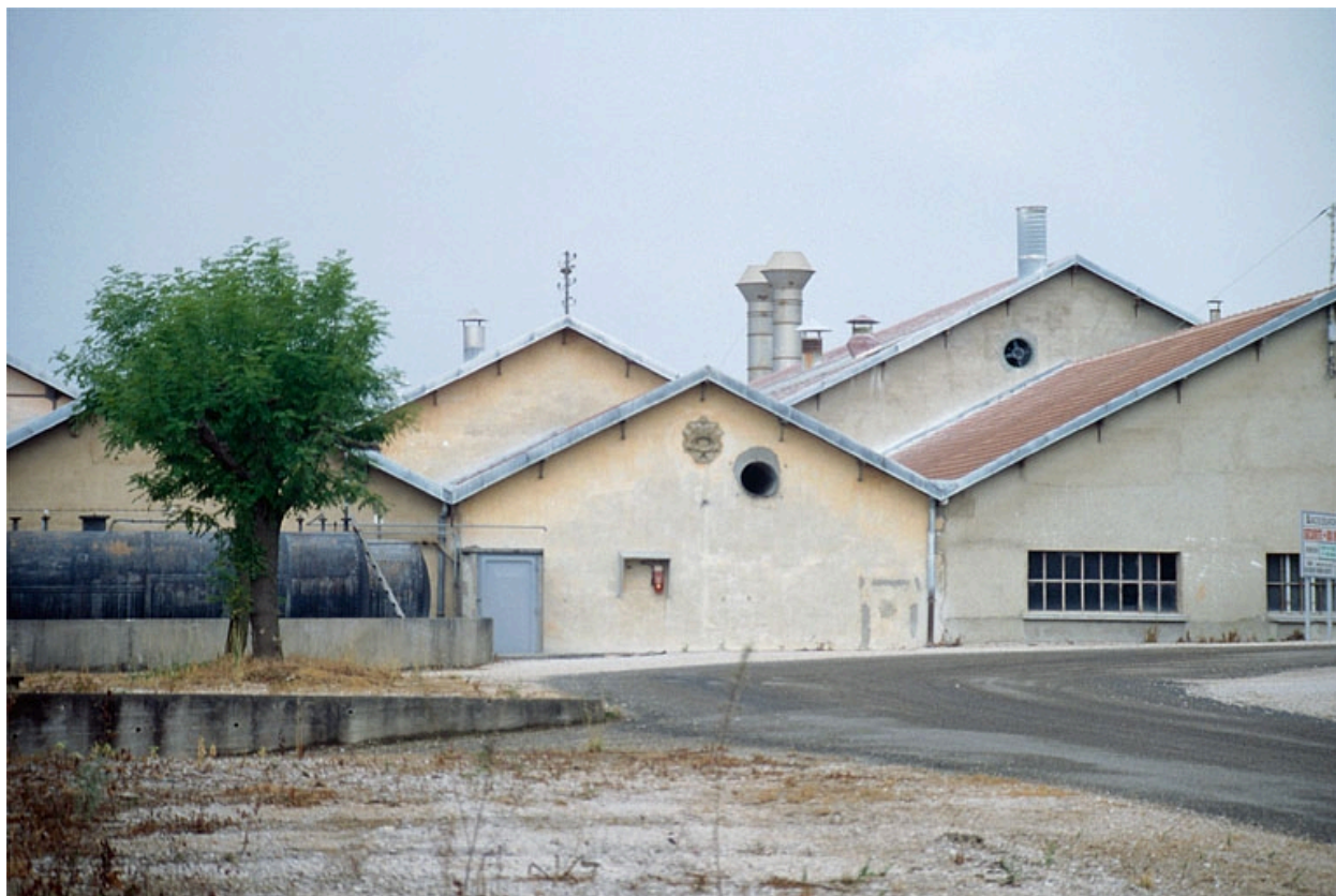
Usine de grès et de porcelaine des Ets Jacob-Delafon et Cie, Damparis.
