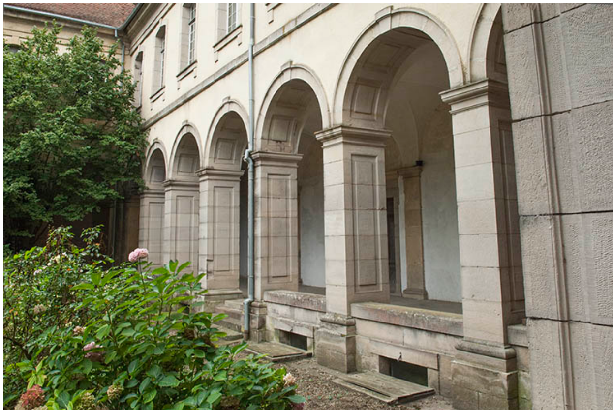
Vue rapprochée de la galerie est.
