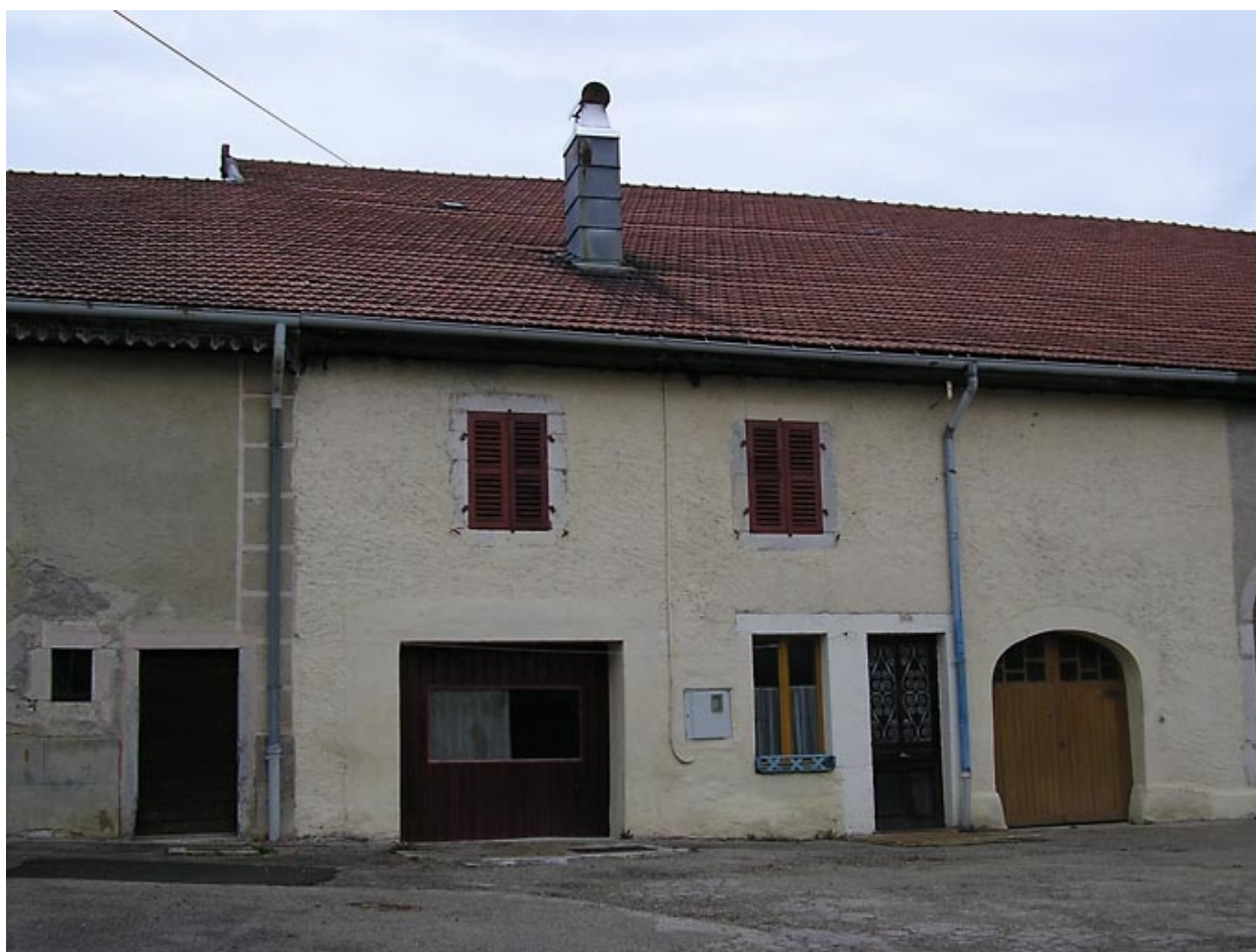
Vue latérale de la façade antérieure.
