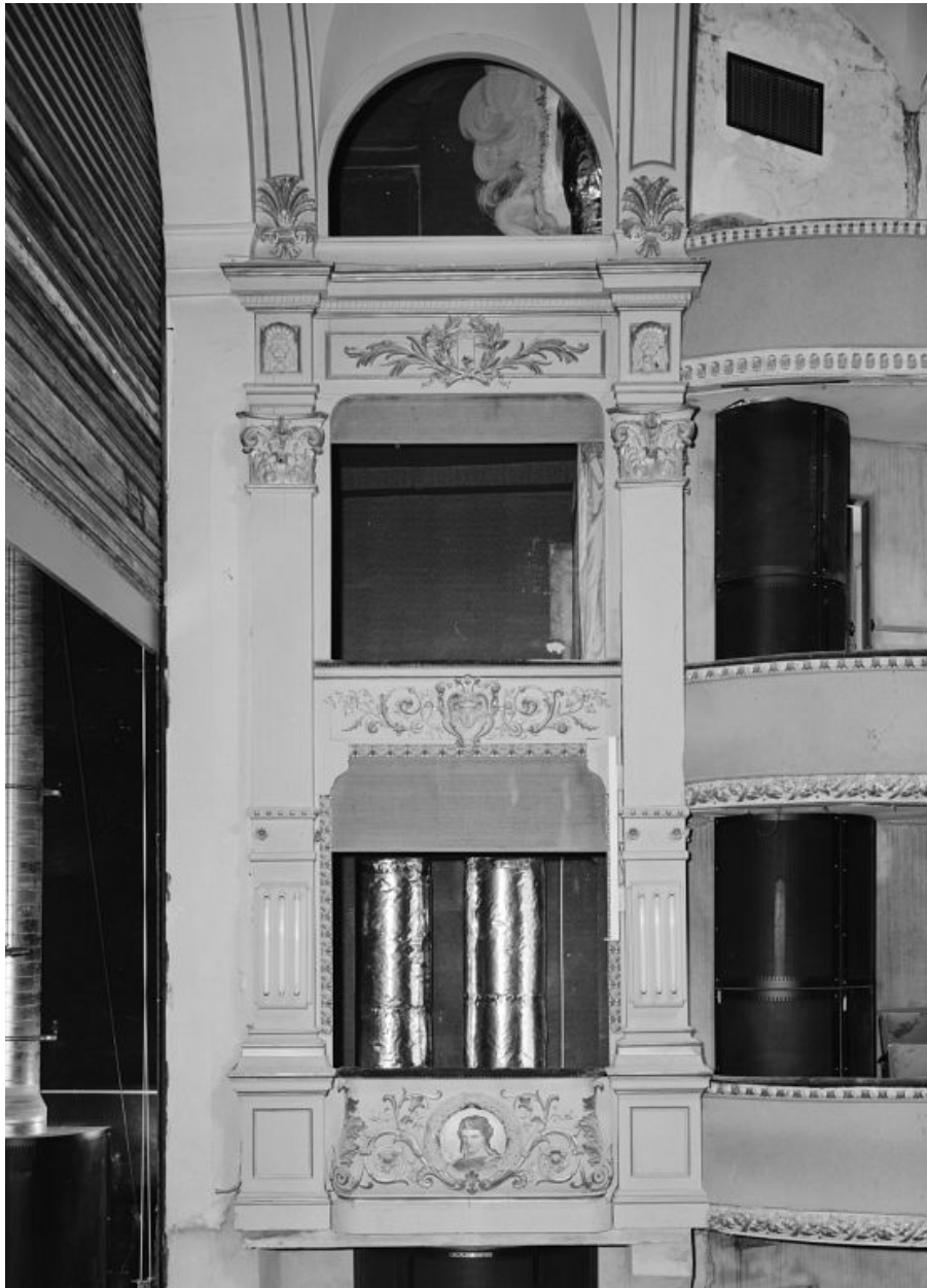
Salle : loges d'avant-scène, côté cour, en 1988, avant restauration.
