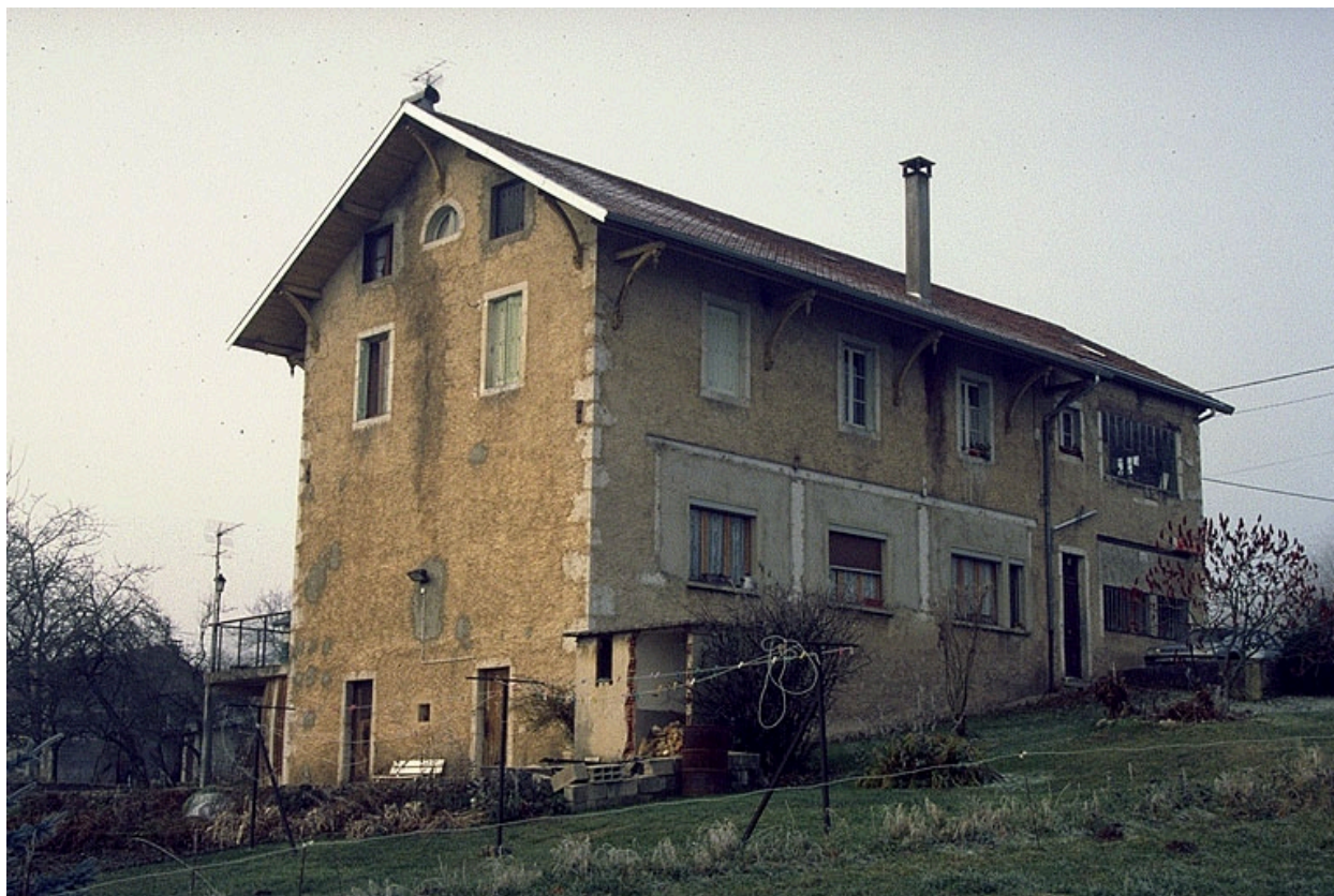
Façades postérieure et latérale gauche.
