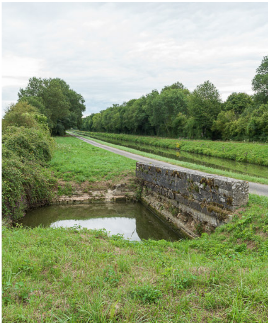
Vue de l'aqueduc.
