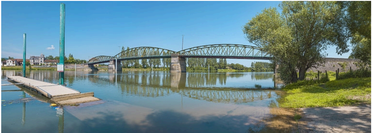
Le pont de Fleurville, vu d'aval, depuis la rive gauche.
