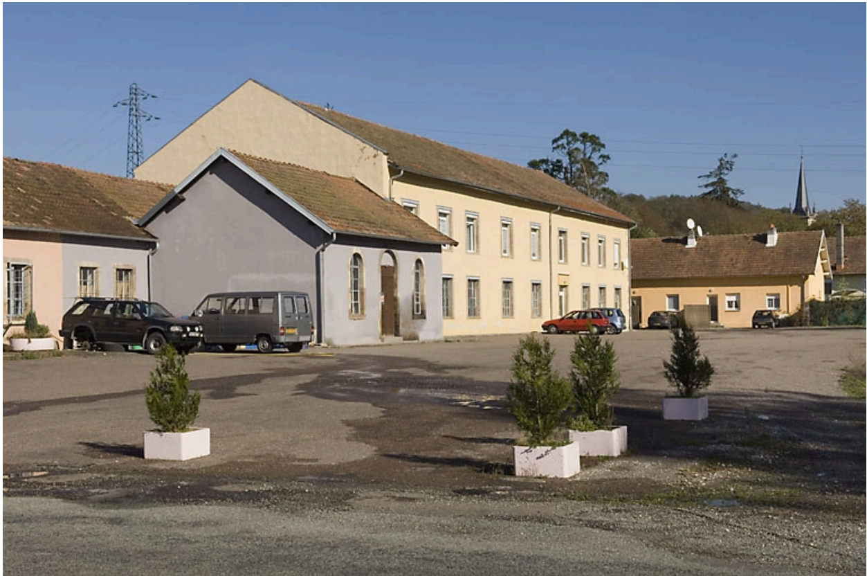
Façades sud. Chaufferie et atelier de fabrication (?).
