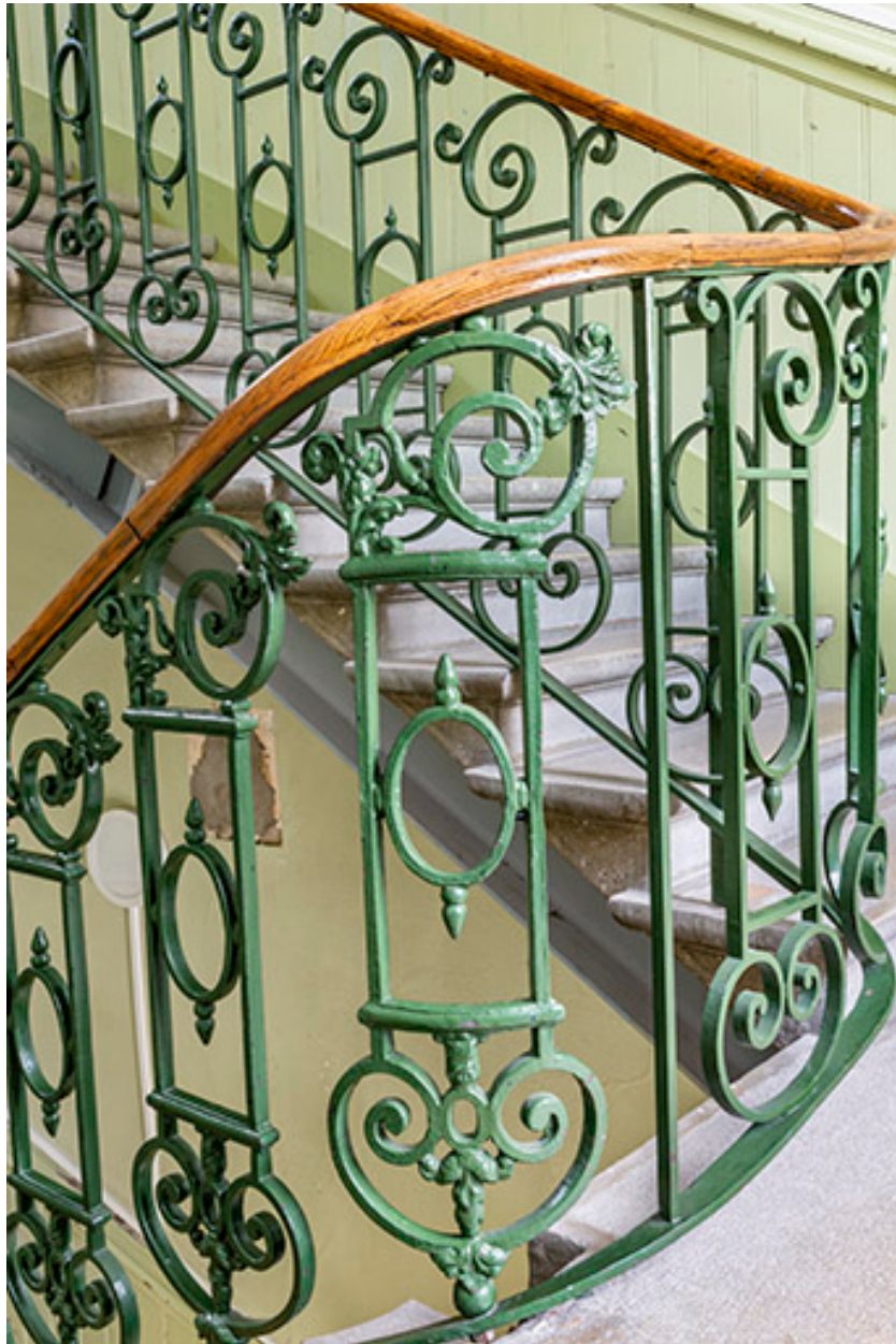
Bâtiment Proudhon : ferronnerie du garde-corps de l'escalier principal.
