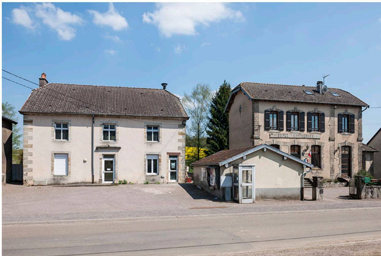
Vue d'ensemble avec l'ancienne école.
