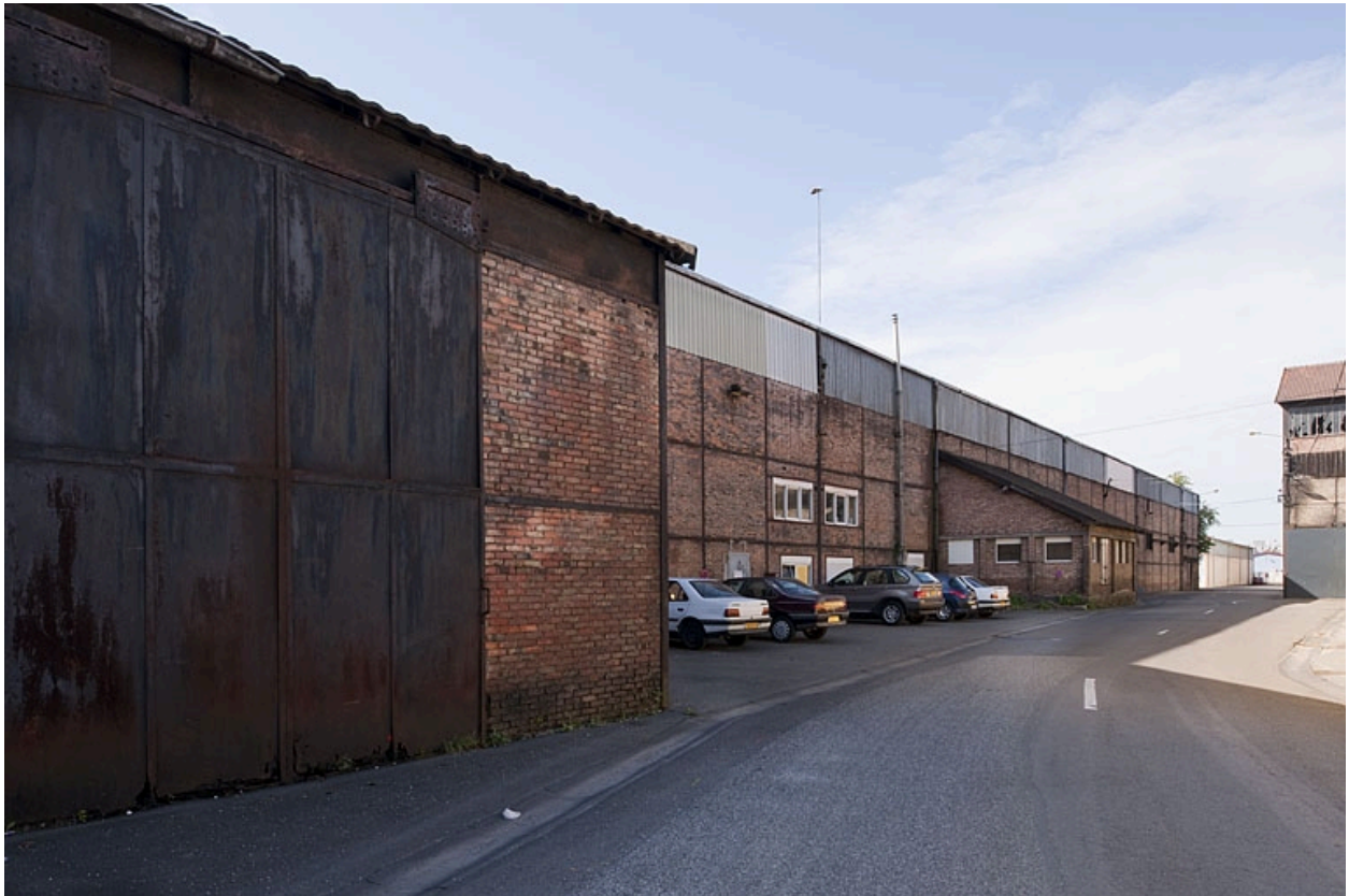
Façade nord de l'atelier de laminage.
