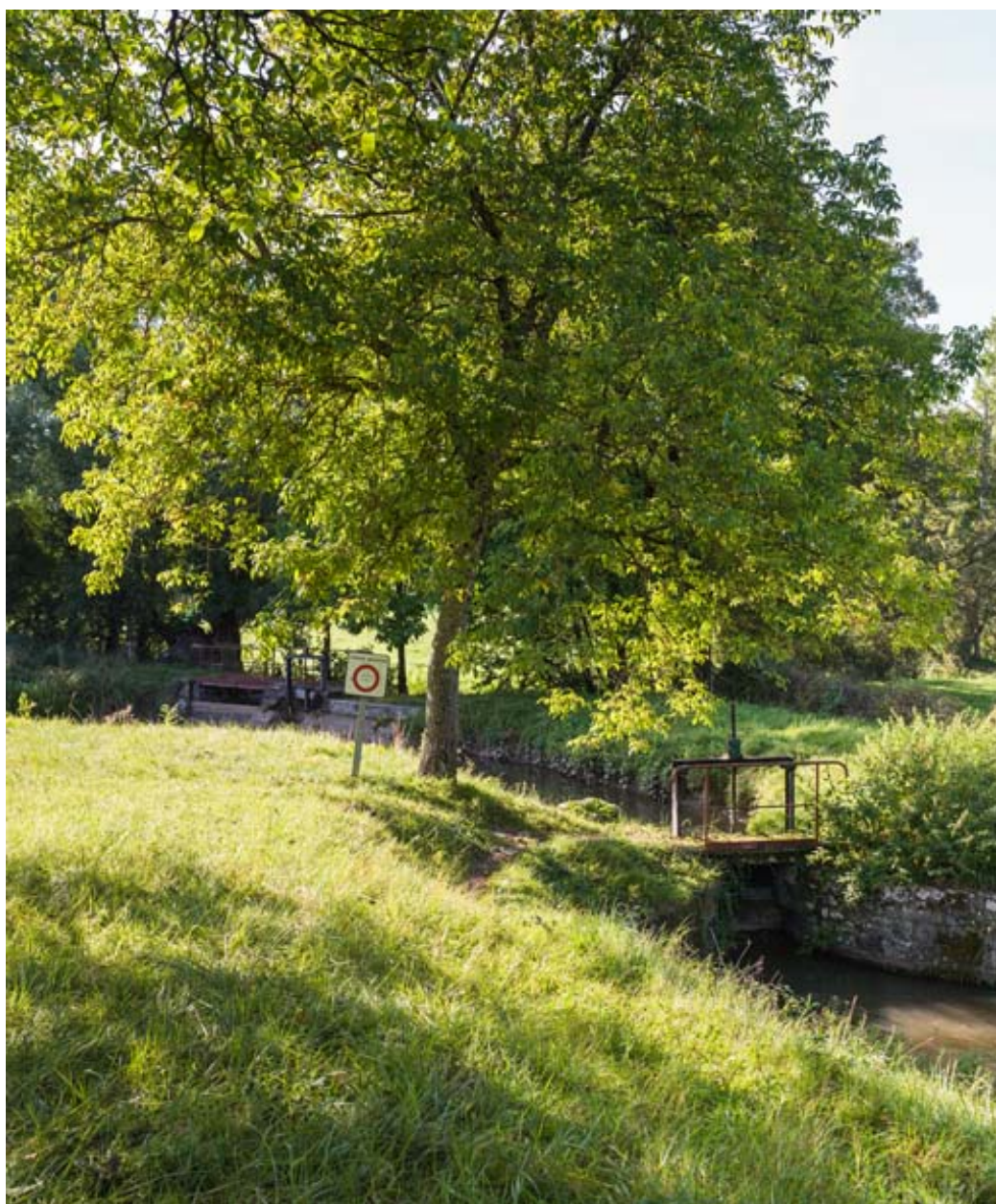
Vue de la rigole maçonnée.
