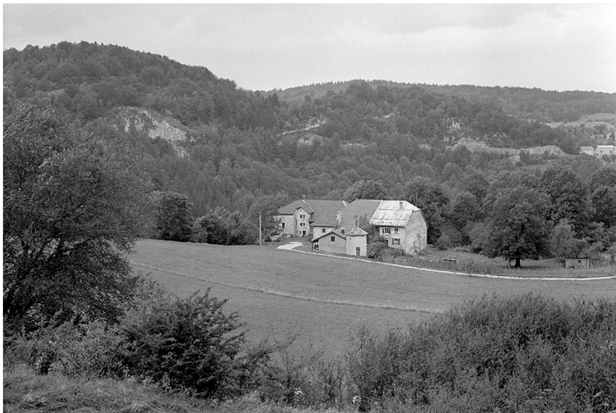
Vue générale, façade sud-est.
