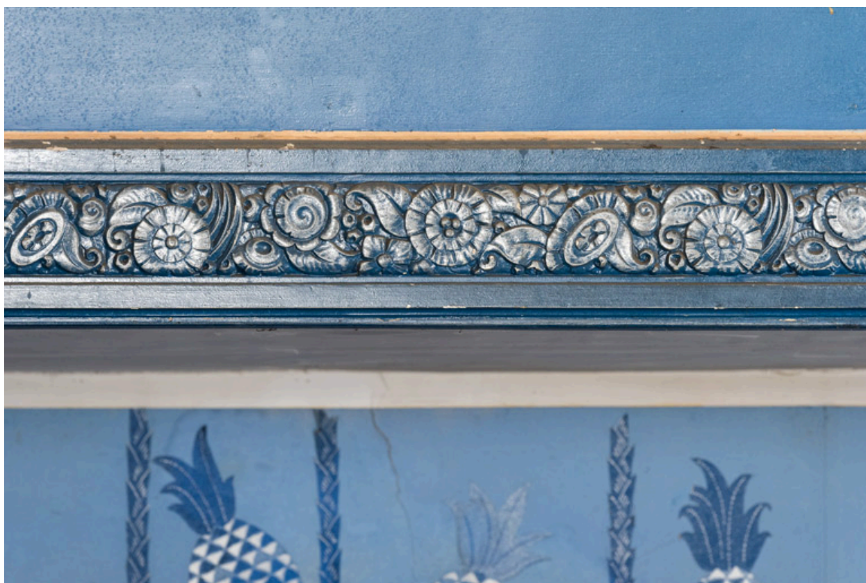
Décor en stuc sur le garde-corps du balcon.
