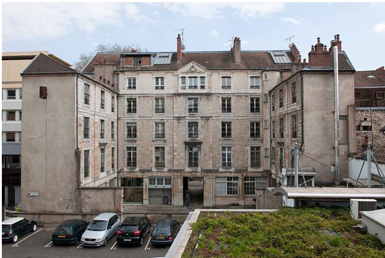
Vue d'ensemble des façades sur cour.
