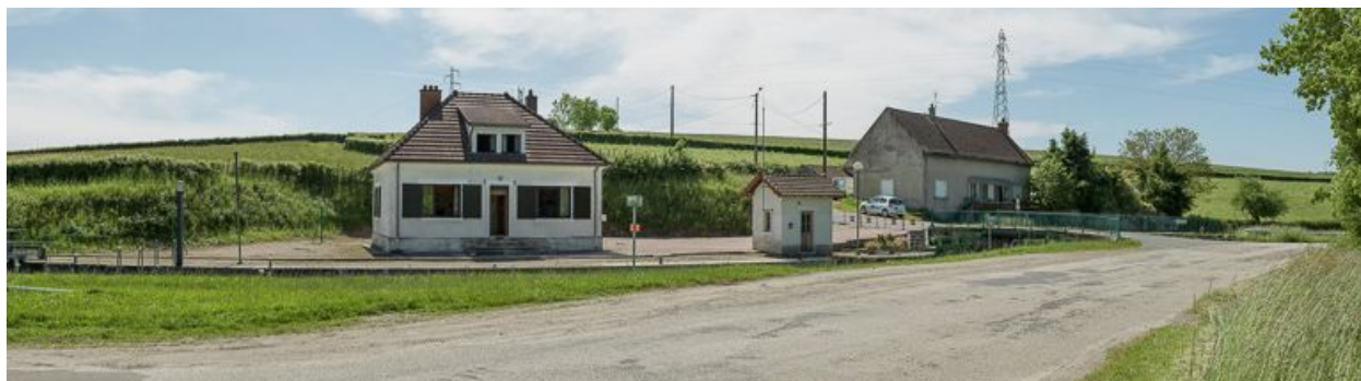
Vue d'ensemble du site, depuis l'étang.
