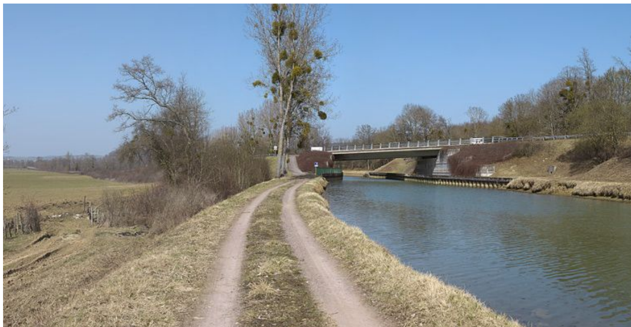
Vue d'ensemble du pont.
