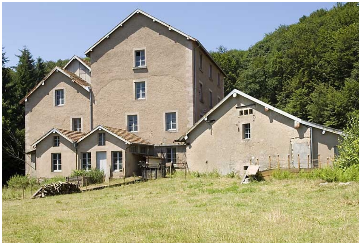
Les façades sud-est.
